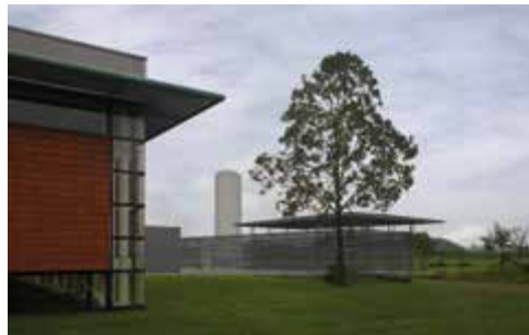
Nieuwe zuiveringsinstallatie in Bergambacht
